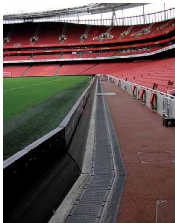
Сервисные каналы на стадионе Arsenal
